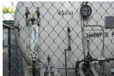
พื้นที่ทำงานที่ตรวจสอบได้ยาก
